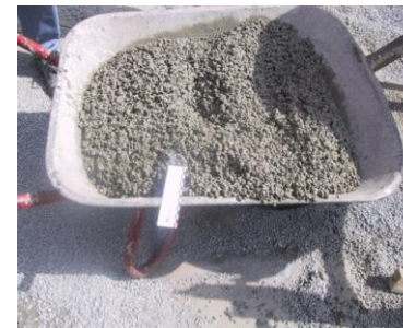
Frisch angemischter Dränbeton, hier Körnung 5/8 mm als Bettungsmaterial
