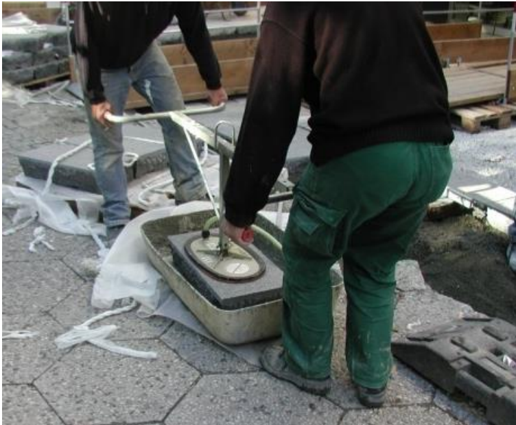
Abb. 1: Verlegung einer Natursteinplatte mittels Vakuum-Verlegegerät
