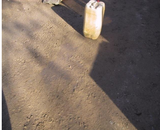
Schottertragschicht gemäß ZTV SoB-StB 04
