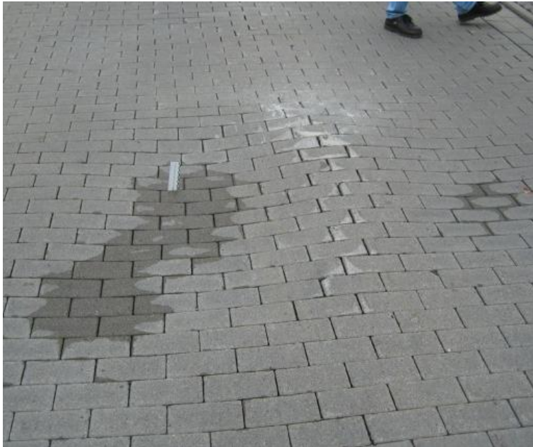
Abb. 1: Verformungen im Betonsteinpflaster „Grundbruch – keine reversiblen Verformungen mehr möglich“
