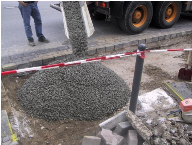
Dränbeton 2/16 mm beim Entladen
