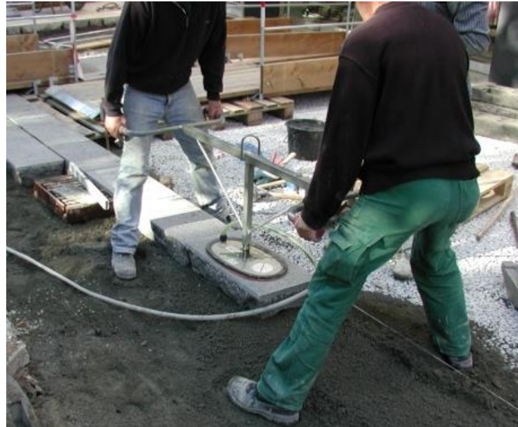
Abb. 1: Verlegung einer Natursteinplatte mittels Vakuum-Verlegegerät
